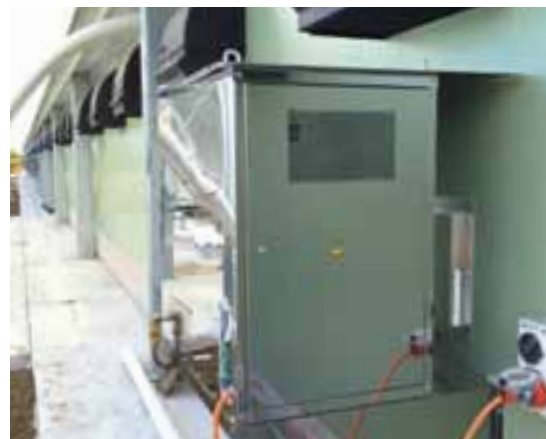
Montáž vně budovy
